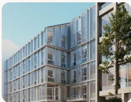
Immeuble le Rivoli à Issy-les-Moulineaux
